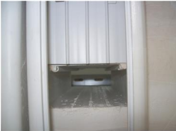
Sistem odası iç duvarı
