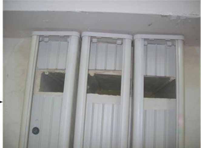
Sistem odası iç duvarı
