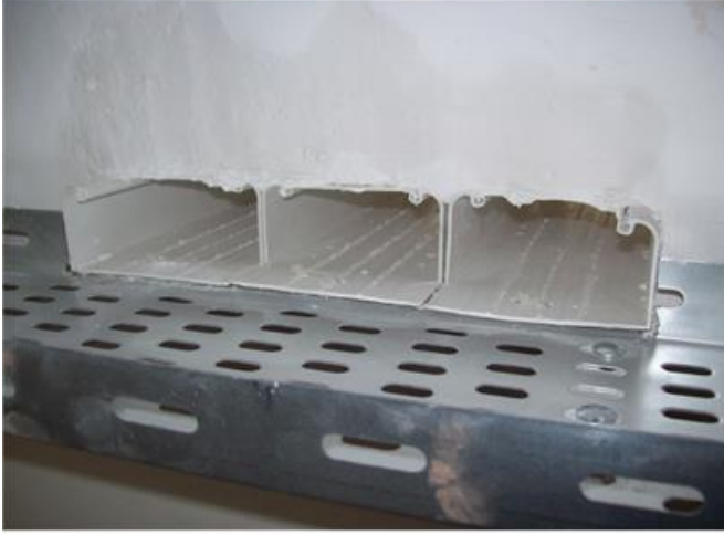
Sistem odası dış duvarı
